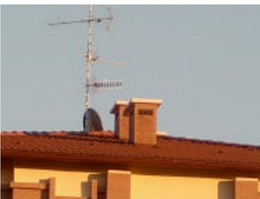
L'impianto di ricezione TV è unico per ogni palazzina ed è costituito da un'antenna centralizzata per la ricezione dei canali RAI e di 5 canali privati, con predisposizione del centralino per aggiunta di ulteriori canali privati.
