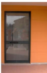
Il portoncino principale di accesso al fabbricato verrà realizzato con profili in alluminio preverniciato con vetri stratificati, completo di elettroserratura, di pompa per la chiusura automatica, di maniglioni e tutto quanto necessario al buon funzionamento.
