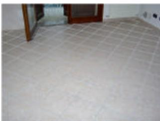
Tutti i locali della zona giorno saranno pavimentati con mattonelle di ceramica monocottura di prima scelta nel formato di cm 30x30, o similare, del prezzo netto di acquisto di € 10,00 il m<sup>2</sup>, posati in diagonale con fughe accostate.
